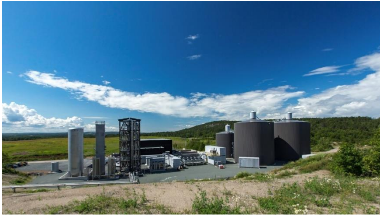
Figure 2. Usine de biométhanisation de la SEMER. Crédit photo : JoanSullivanPhotography.com
